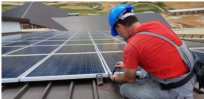
Bild: Montage einer PV-Dachanlage, Foto: pixabay.com
